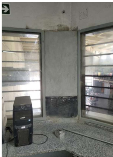
Figura 12 (c). Rehabilitación de columna (revestimiento de FRP)
