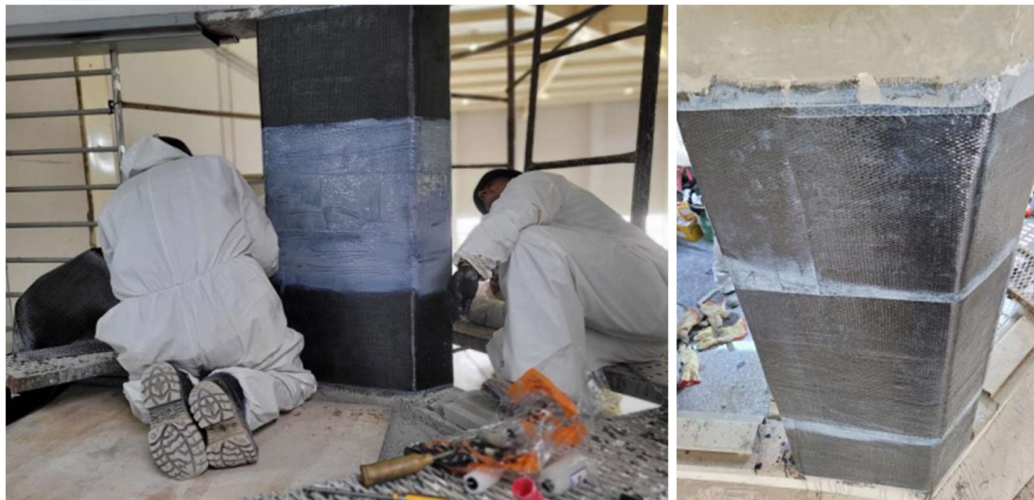
Figura 12 (b). Rehabilitación de columna (colocación de FRP)
