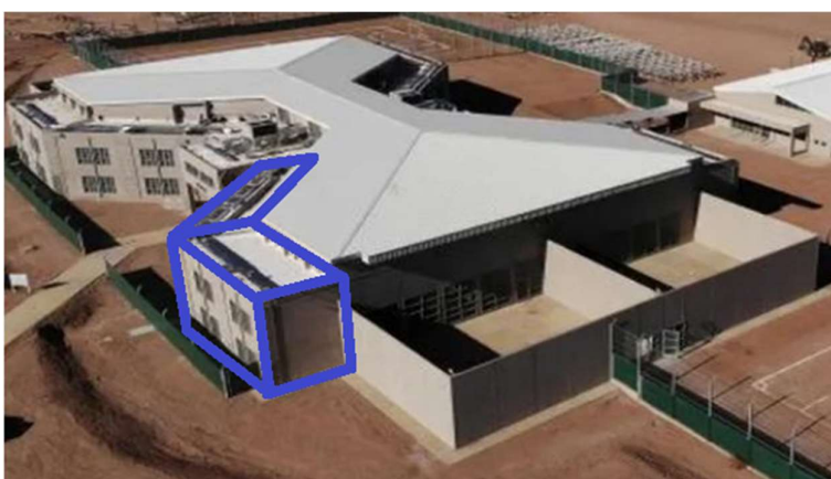
Figura 1 (b). Vista general del edificio (edificación de hormigón armado resaltada en azul en el sector D)
