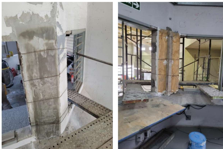
Figura 12 (a). Rehabilitación de columna (preparación de la superficie de la columna)
