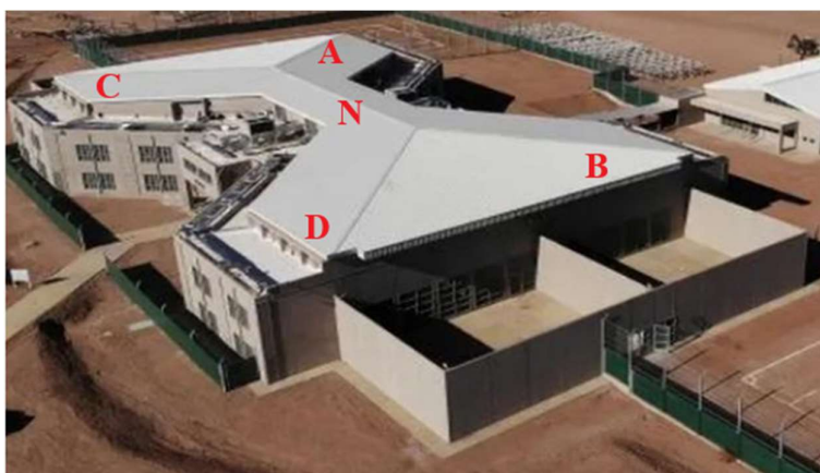
Figura 1 (a). Vista general del edificio (identificación de sectores A, B, C, D y N)
