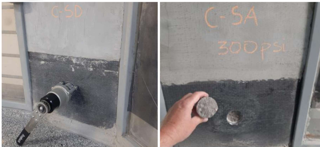
Figura 12 (d). Rehabilitación de columna (control de calidad de adhesión FRP al sustrato)
