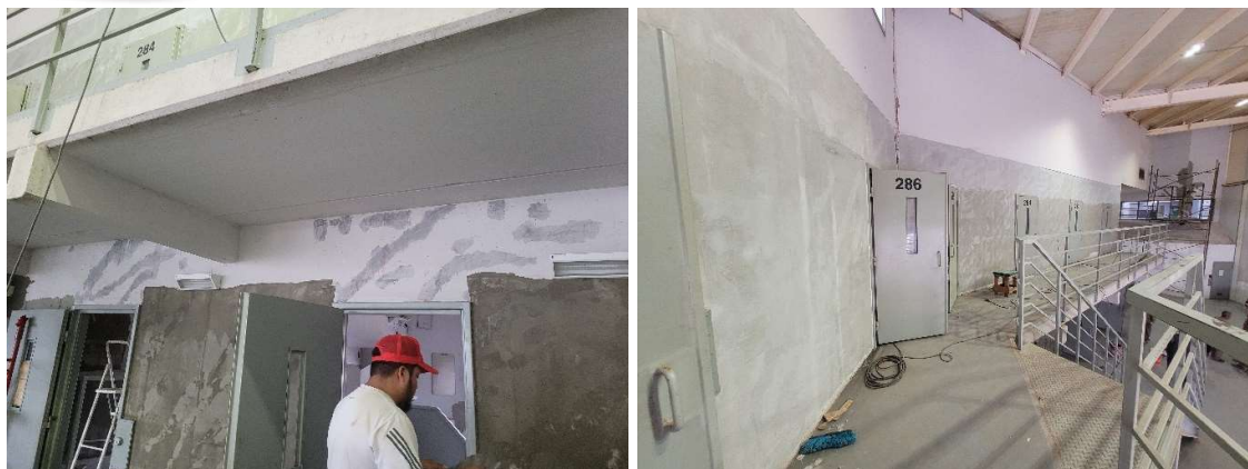
Figura 13 (a). Rehabilitación de tabiques
