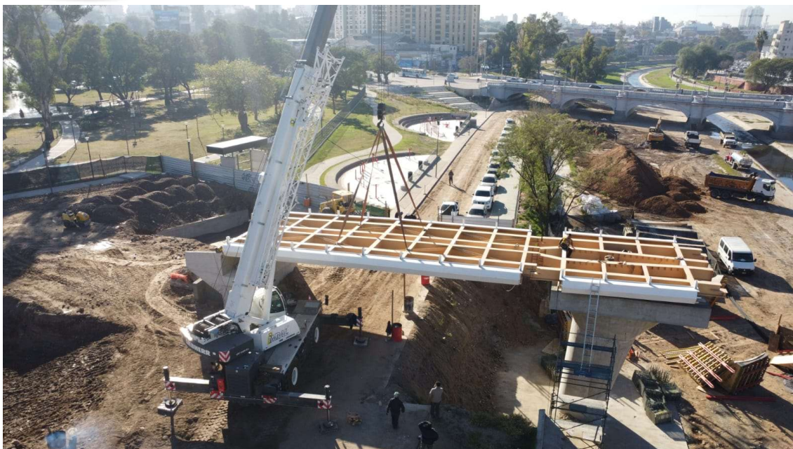
Figura 19. Imagen de la parte metálica del tablero
