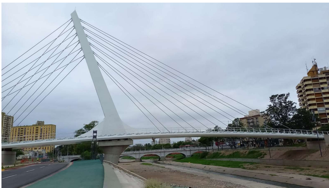
Figura 1. Imagen del Puente terminado desde aguas arriba. (Fuente, foto de los autores)
