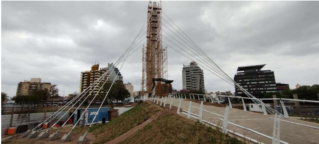
Figura 17. Estado de la obra al terminar el montaje de los tirantes (Foto gentileza del Ing. Rodrigo Manzano)
