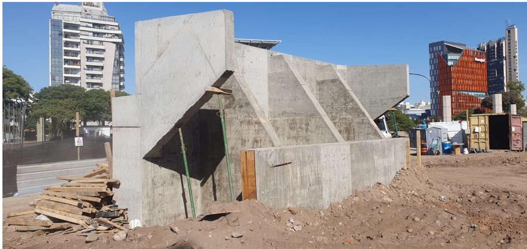
Figura 12. Imagen del Estribo Norte.
