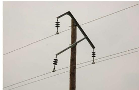
Figura 2: Cabezal del soporte. Cruzeta tipo canadiense, aisladores, conductores e hilo de guardia
