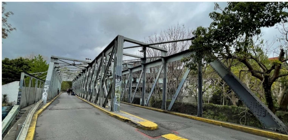
Figura 2: Puente Ciudad de la Paz
