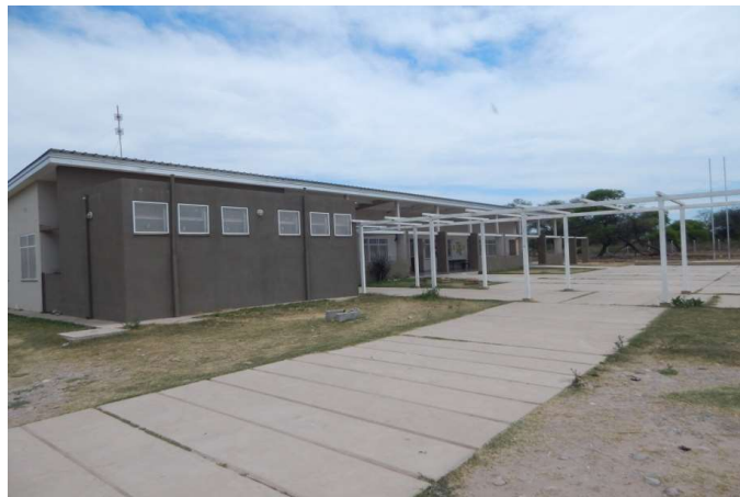
Foto 12 – Edificio escolar nuevo sin daños El Galpón, Salta
