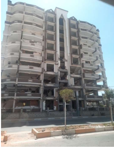
Figura 4 – Edificios con fallas
