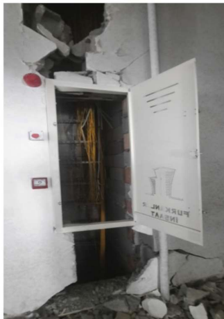
Figura 15 – Daños en instalaciones eléctricas
