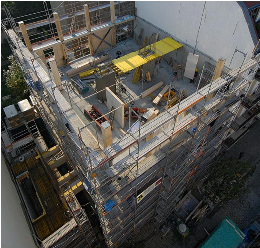
Figura 5: vista aérea durante la construcción.
