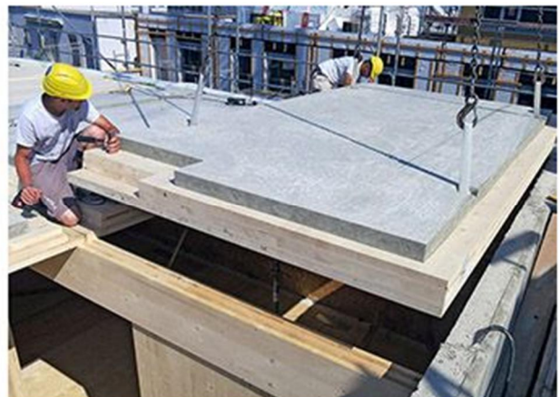
Figura 17: Composición del sistema de piso y etapa de montaje.
