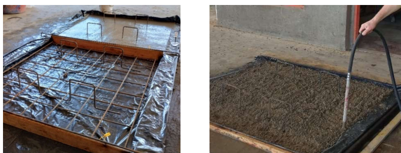
Figura 2. Preparación y hormigonado de losas
