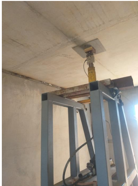
Figura 6. Ensayo de carga estática sobre panel de techo
