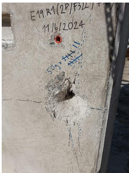
Figura 11. Ensayo de impacto finalizado sobre panel con abertura
