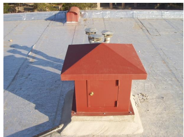
Figura 8: Coberturas metálicas de protección de los sensores externos.
