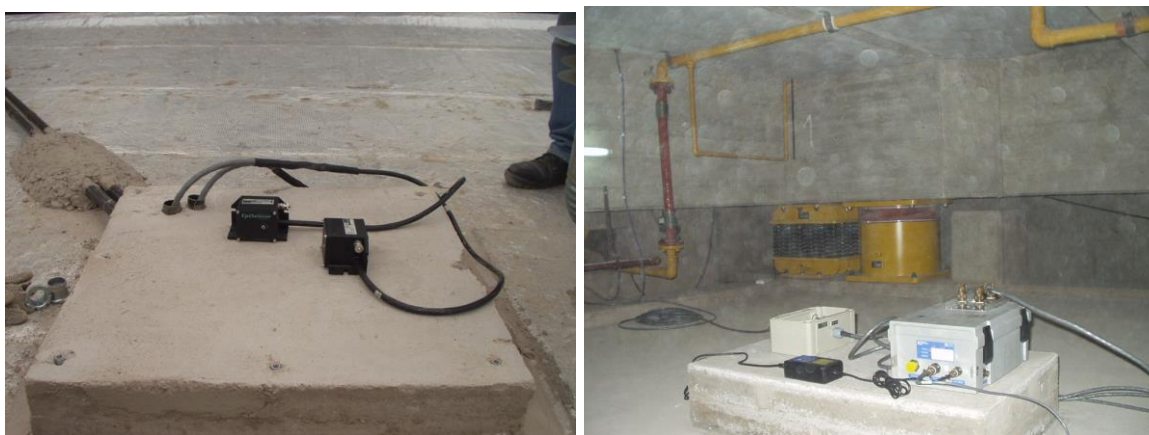
Figura 5: Bases de hormigón simple para fijar el instrumental de medición
