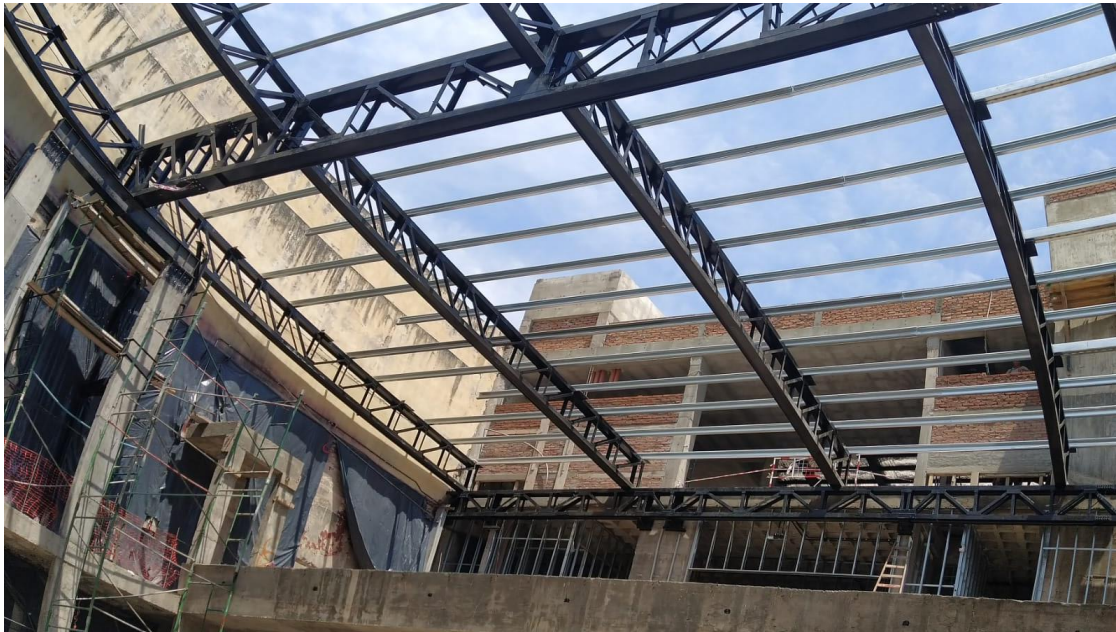
Figura N° 1: Fotografía del Montaje de la Estructura.
