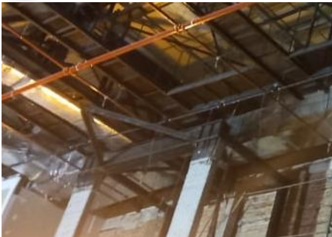
Figura N° 4: Fotografías de la Viga de apeo (2W) de la viga reticulada
