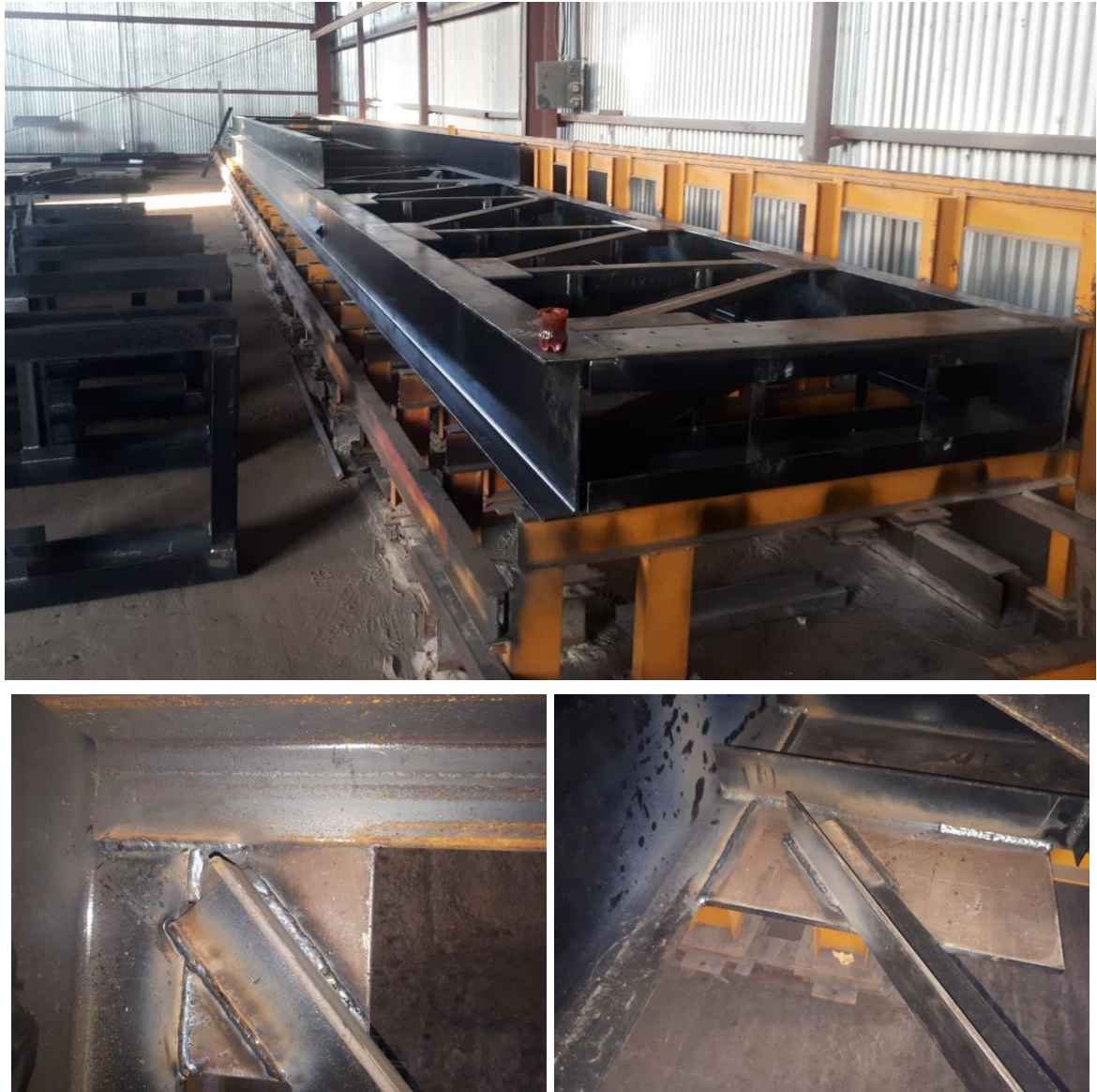
Figura Nº 3: Fotografía de Estructura de Vigas reticuladas de Cubierta. Fabricación en proceso
