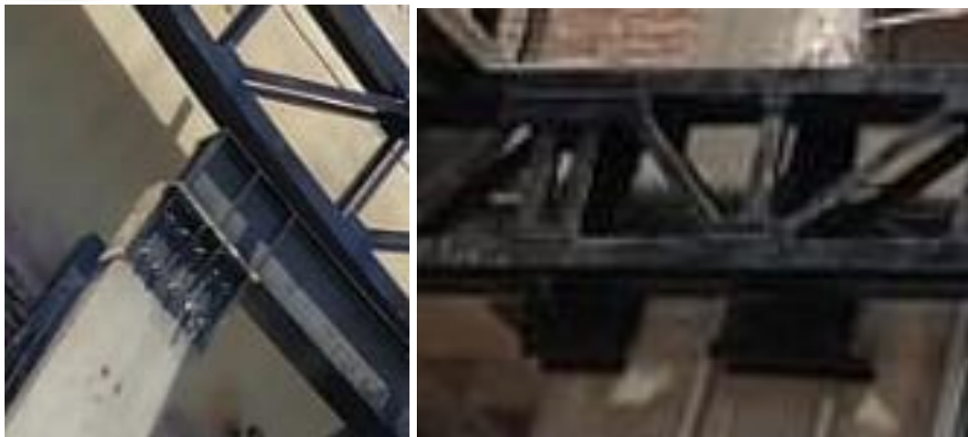
Figura N° 6: Fotografías de insertos. A la izquierda el de la Viga de Apeo y los de la derecha de la viga principal VPR-3
