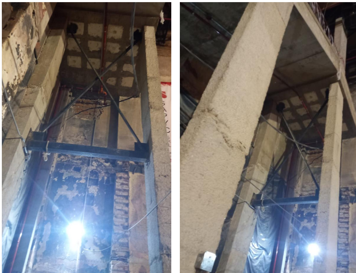
Figura N° 24: Fotos de Arriostramientos de Columnas
