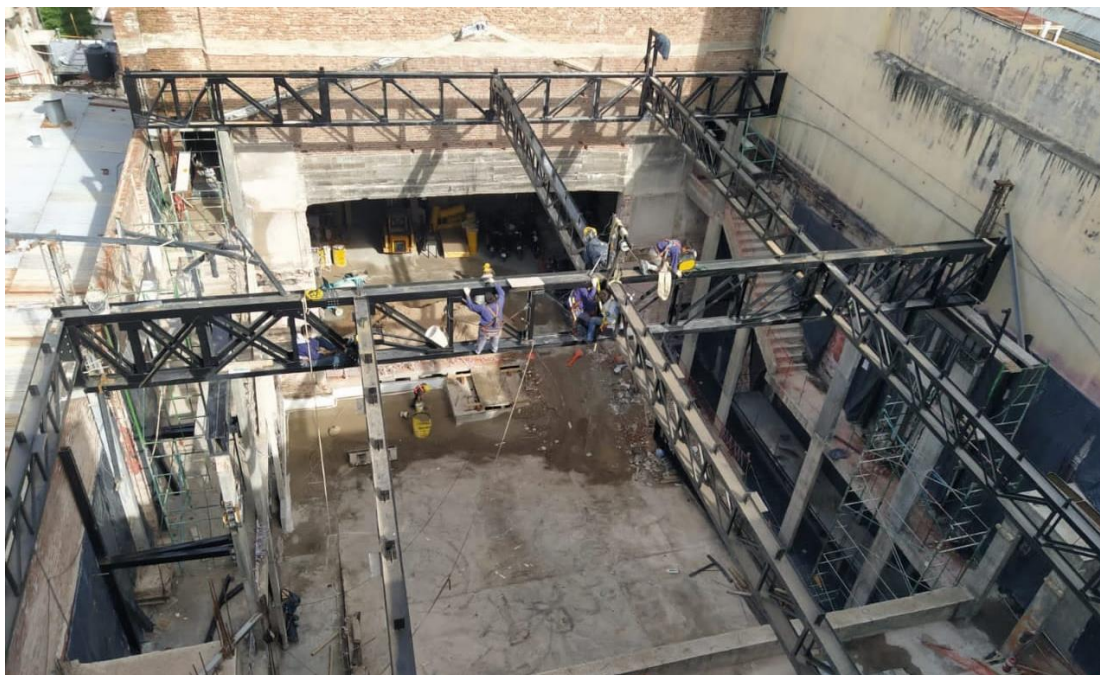
Figura N° 2: Fotografía del Montaje de la Estructura.
