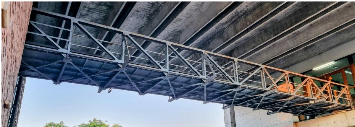
Figura 1. Imagen pasarela analizada
