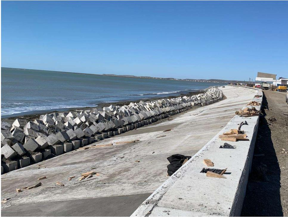
Figura 9. Vista del Muro, Protección y filtro ya construídos.
