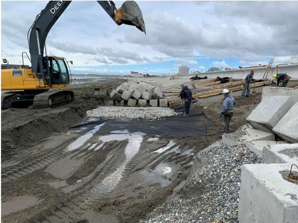
Figura 11. Vista de la construcción del filtro y protección del pie del talud.
