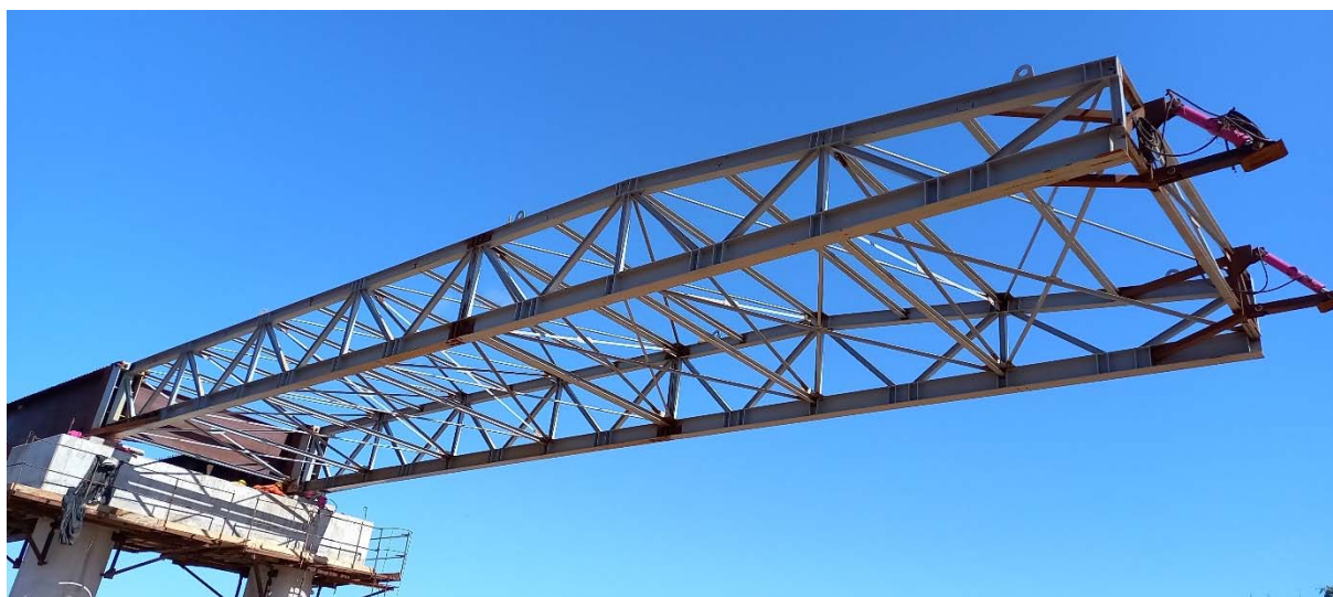
Figura 3. Nariz de lanzamiento de acero reticulada
