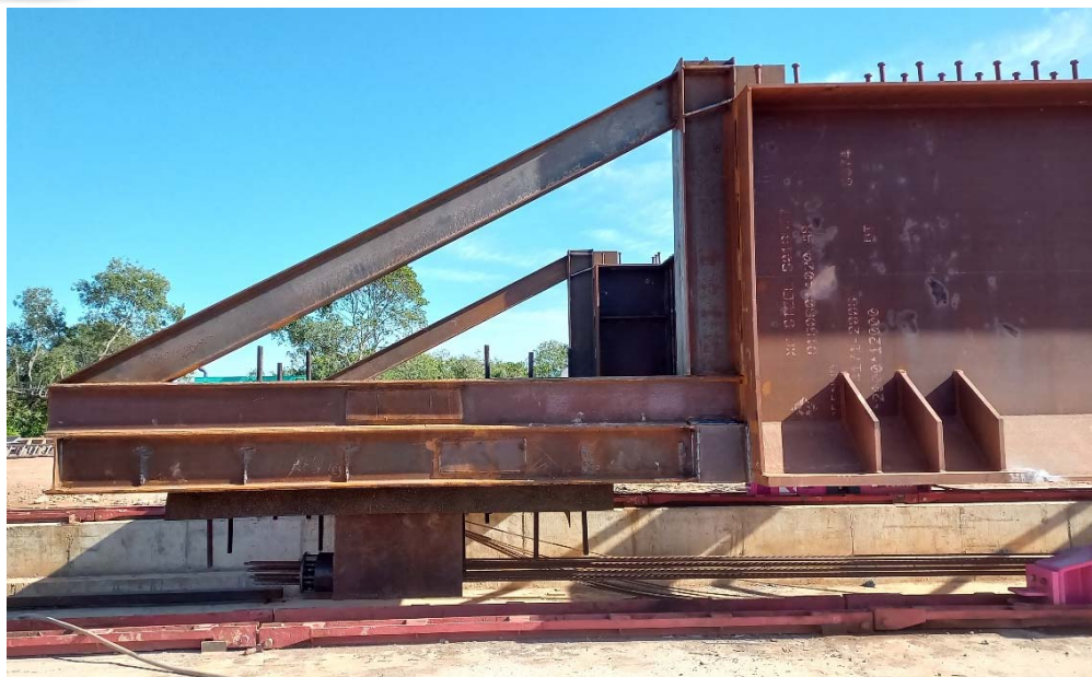
Figura 12. Contranariz ubicada al final del tren de empuje
