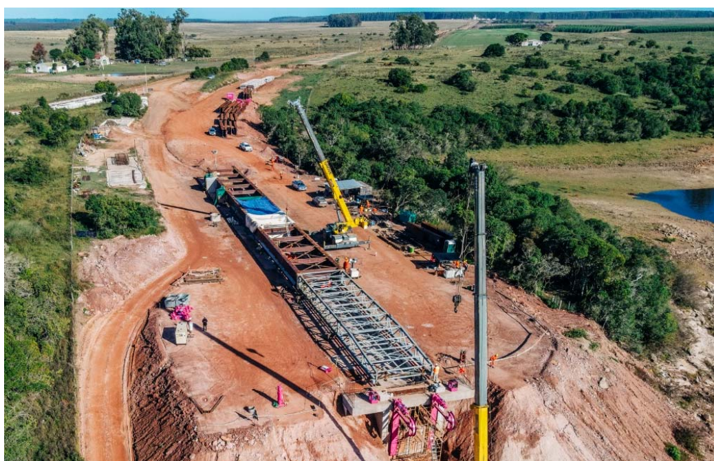
Figura 5. Vista aérea de la pista de ensamble y lanzamiento
