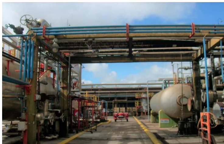
Figura 9. Imagen de la Estructura en la Planta.
