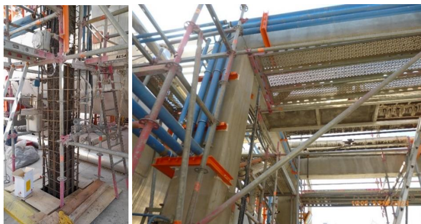
Figura 12. Imágenes de la Ejecución de Refuerzos.
