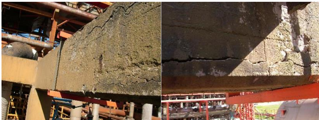
Figura 10. Imágenes de la Inspección Visual.
