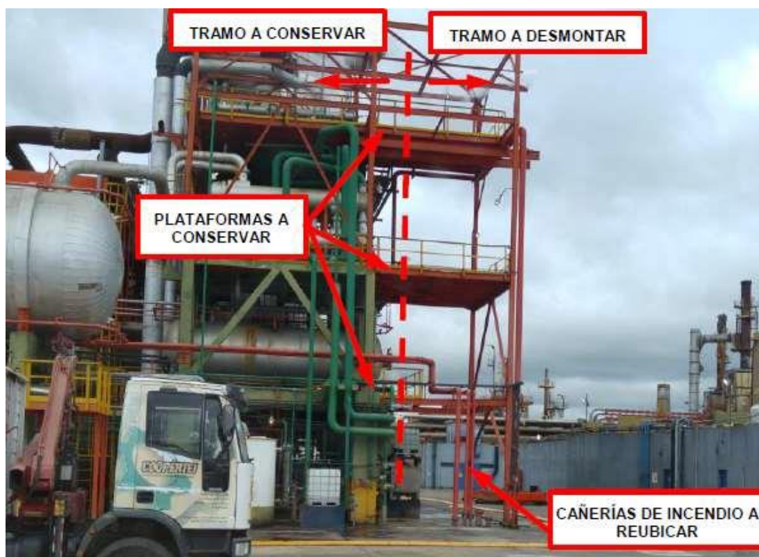
Figura 2. Estructura existente. Sectores por desmontar.
