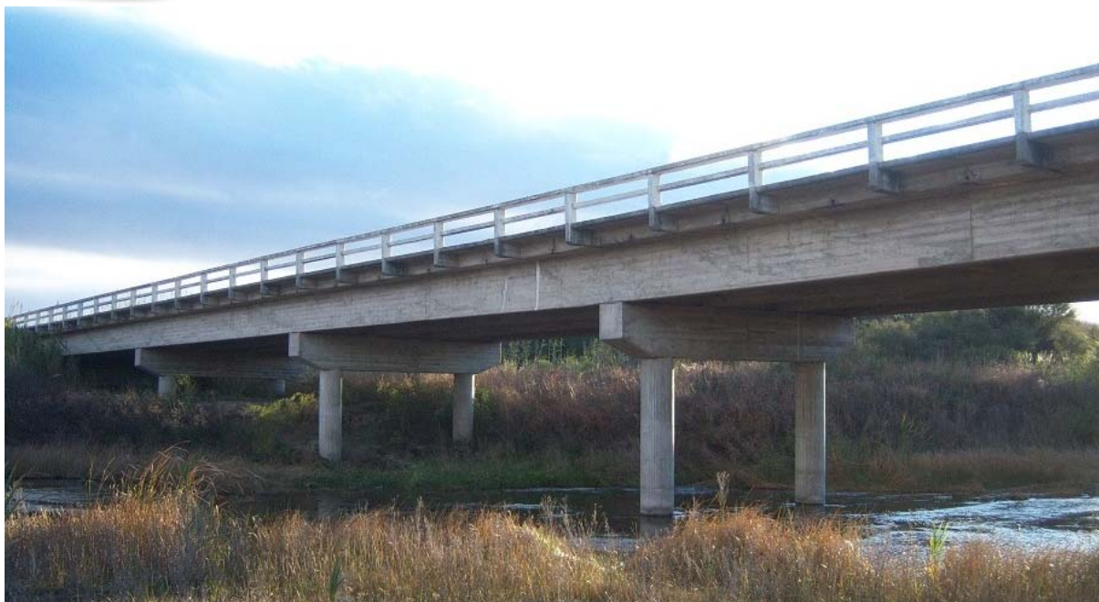
Figura 4. Vista general del Puente sobre A° Chaján en RN N°8
