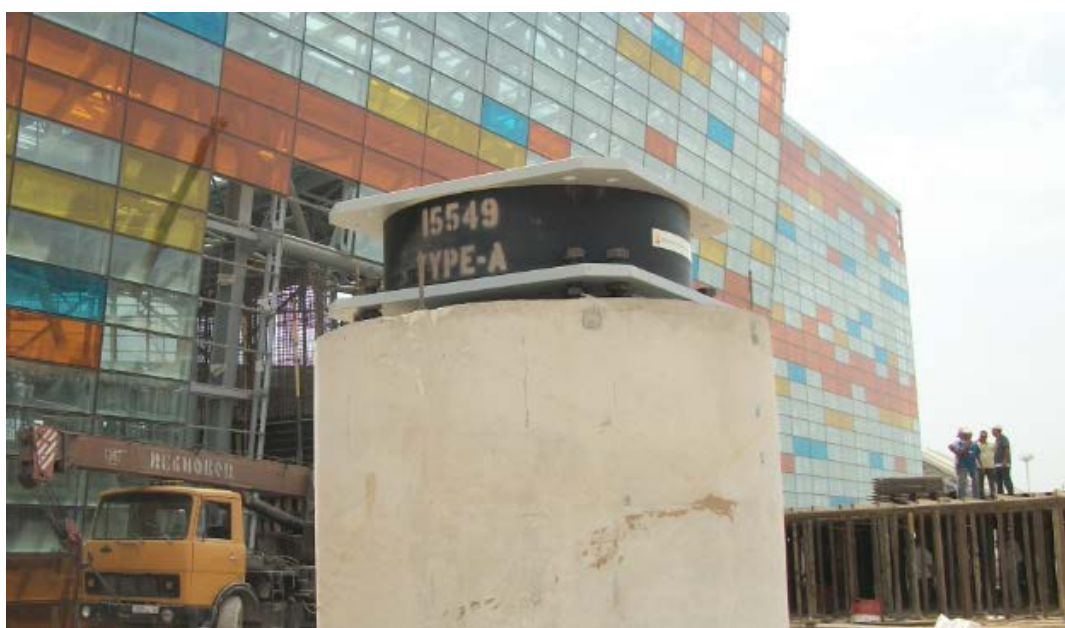
Figura 19. Aislador LRB sobre pila
