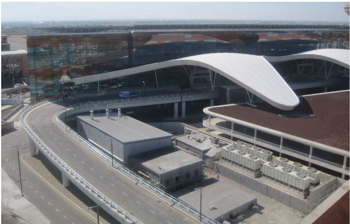
Figura 1. Imagen general del viaducto
