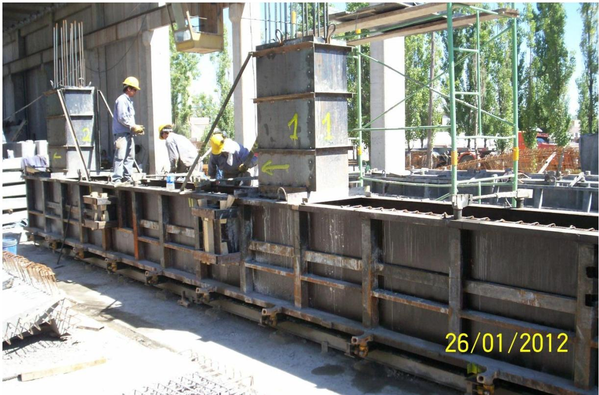
Figura 9 – Encofrado de la columna premoldeada
