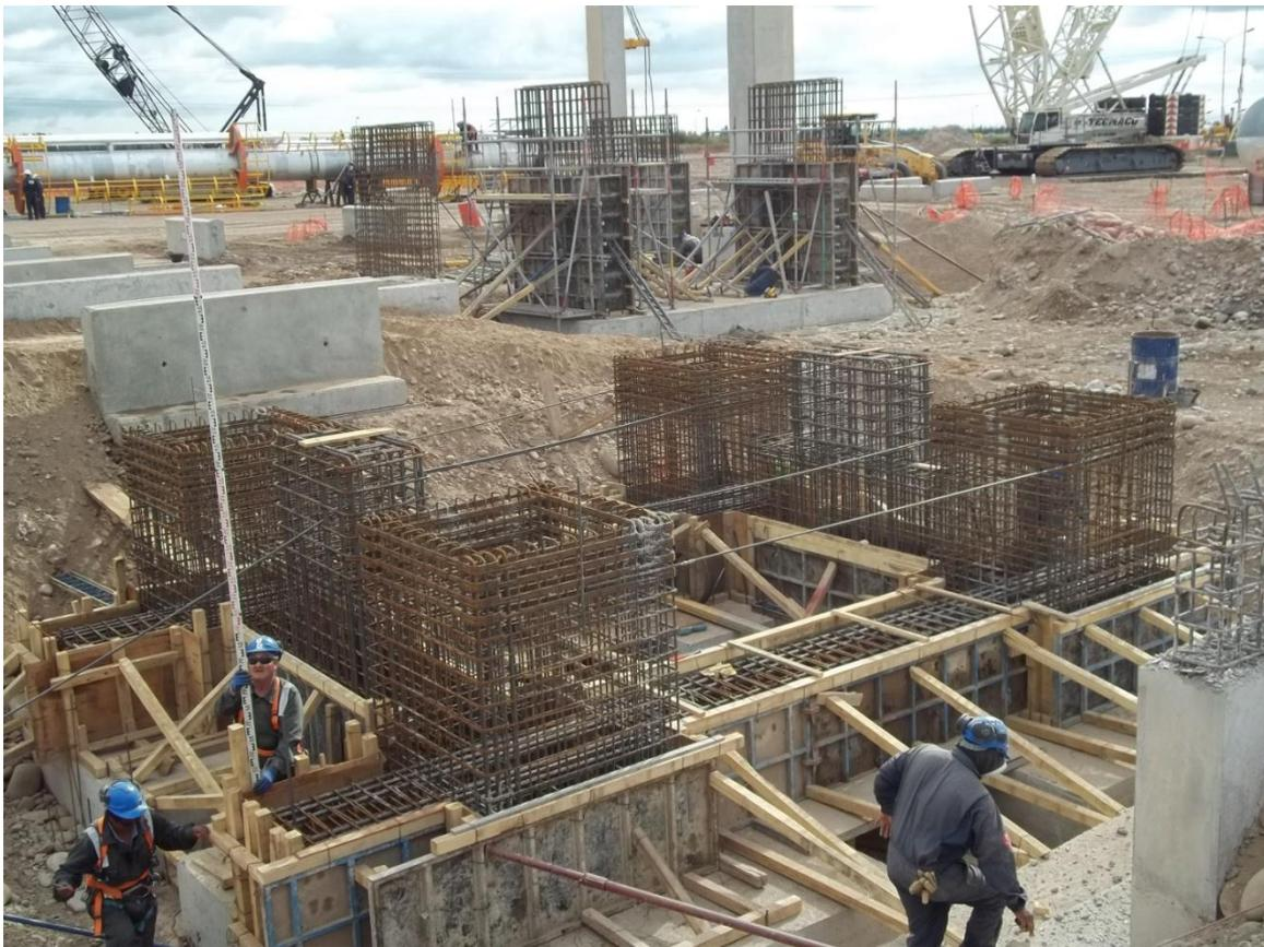
Figura 7 – Armado de las fundaciones
