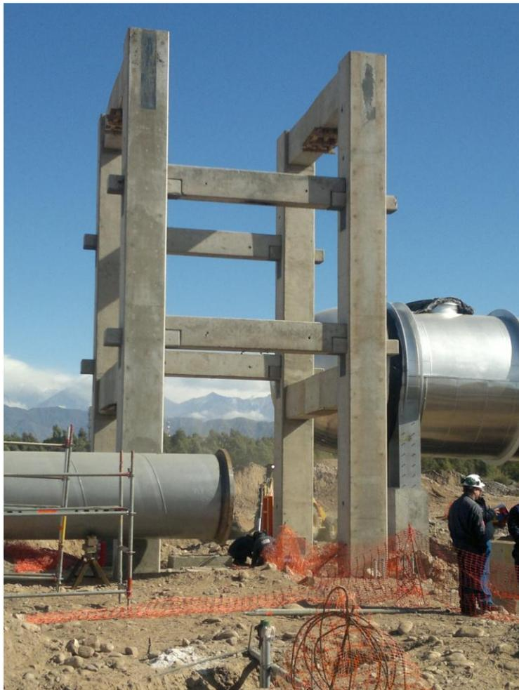
Figura 11 – Montaje del pórtico premoldeado
