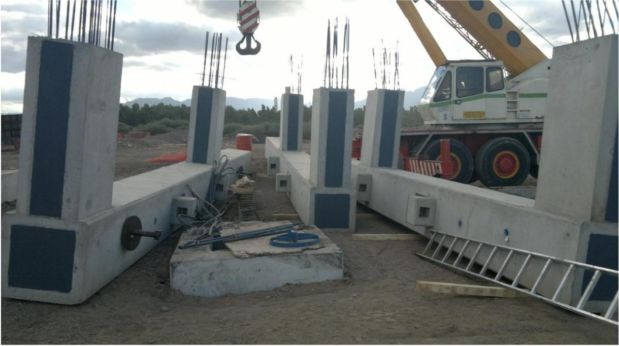
Figura 10 – Acopio de las columnas premoldeadas en el emplazamiento
