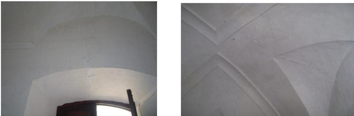
Figura 16. Interior de la bóveda D9 y fisura de la misma
