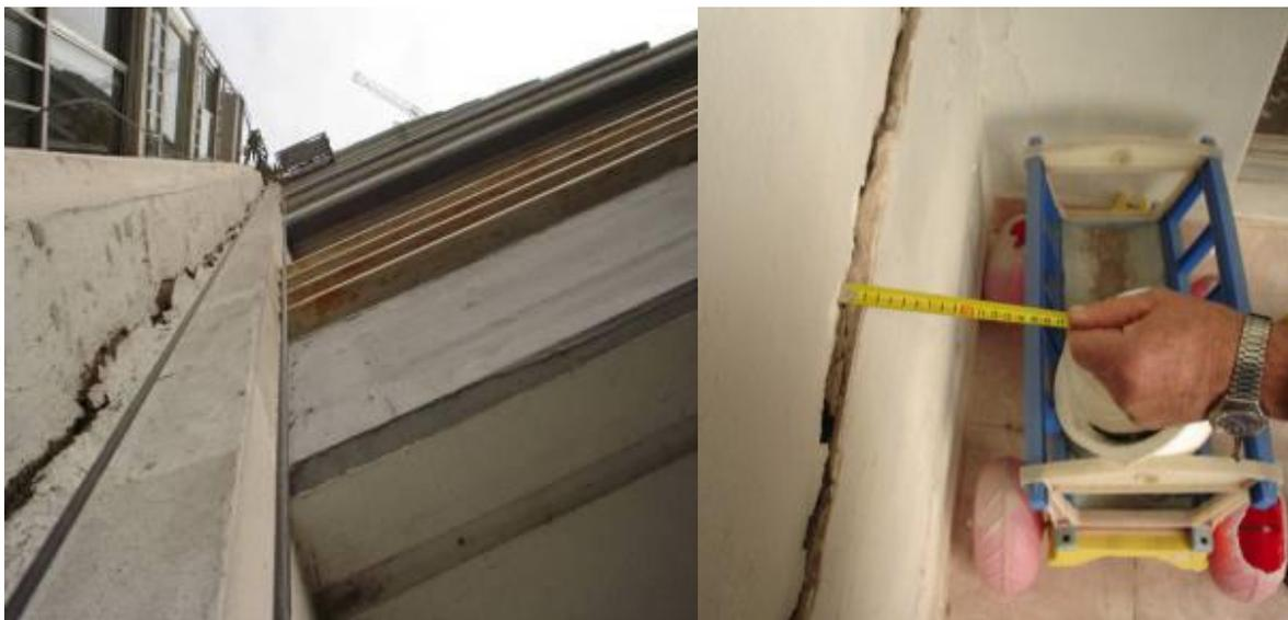
Figura N° 10: Grieta y separación entre edificios “Guanabara” e “Ipanema”. Manifestación del desplazamiento en la medianera de los edificios adyacentes.
