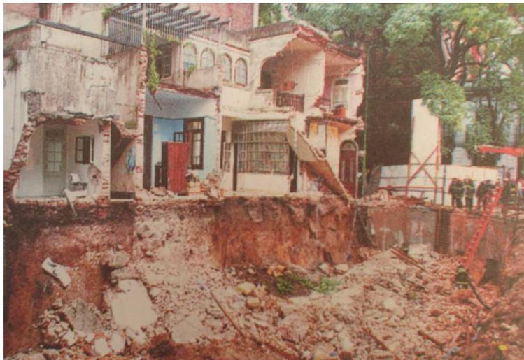
Figura 8: Derrumbe de la medianera causado por errores cometidos en las tareas de submuración, agravado por una escasa vinculación con los muros transversales.
