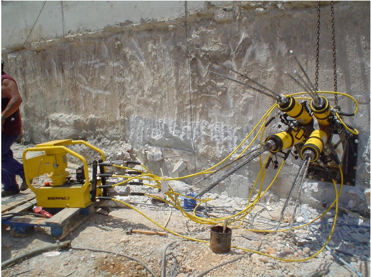
Figura 3. Montaje del sistema de gatos múltiple en el Parking La Vega (Murcia)
