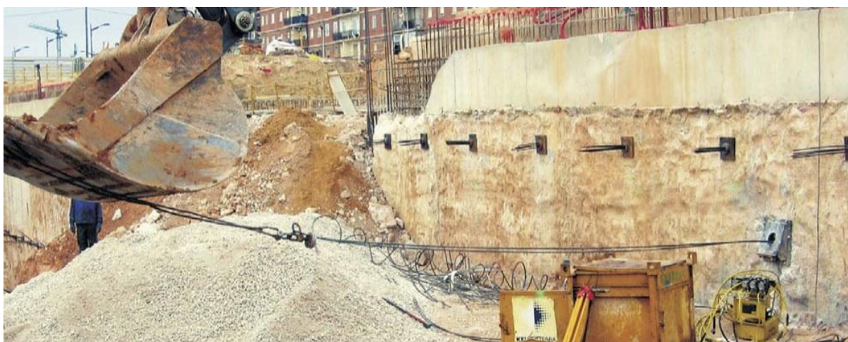
Figura 18. Extracción de una unidad de anclaje con una fuerza de 5-15 ton.
