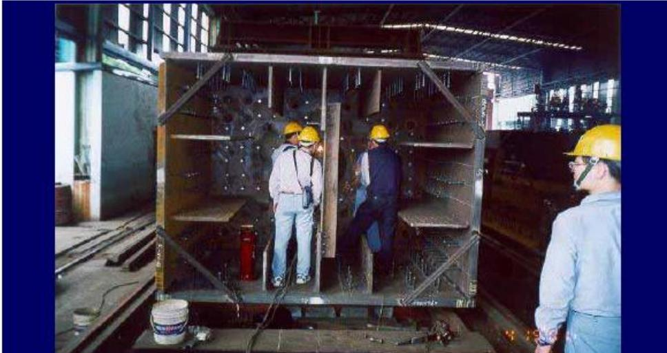
Figura 5."Supercolumna" en proceso de ejecución
