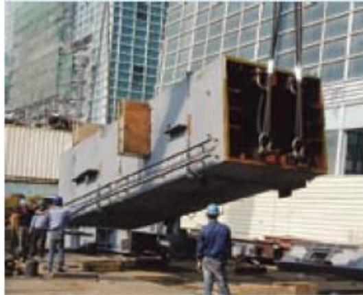
Figura 9. Operaciones de izado de supercolumna
