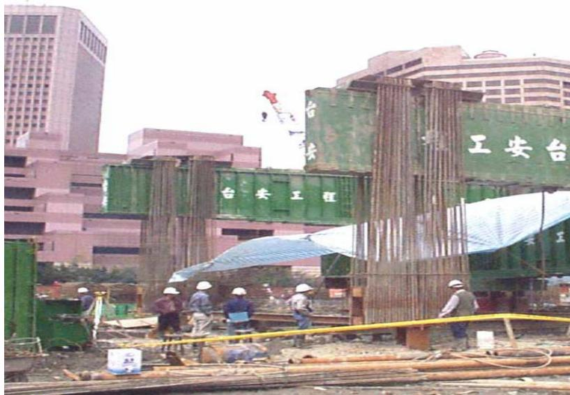
Figura 14. Ensayo de Carga Estático de pilote
