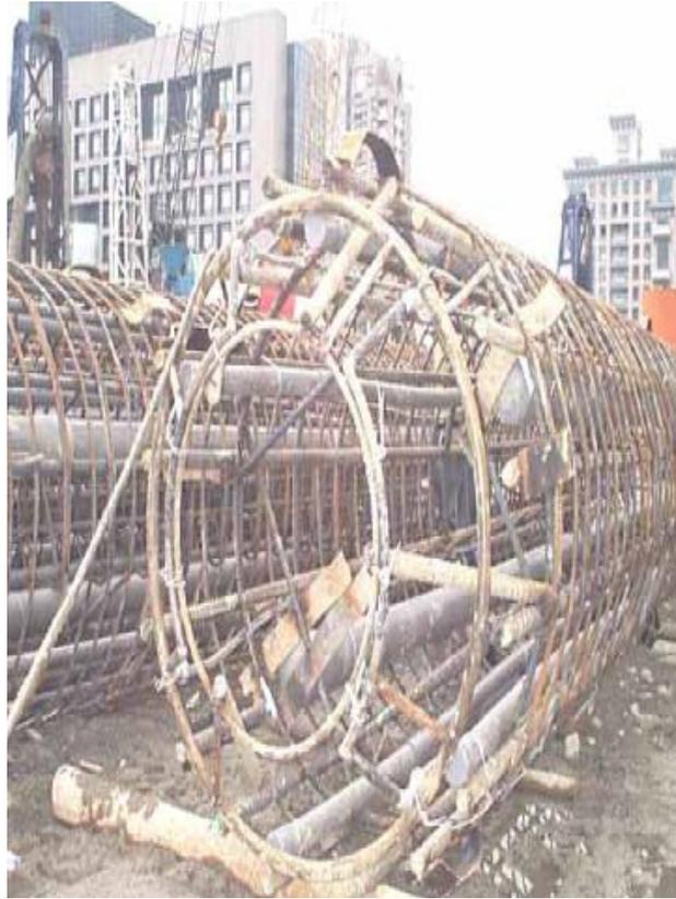
Figura 13. Detalle armaduras de pilotes y conductos perdidos de limpieza
