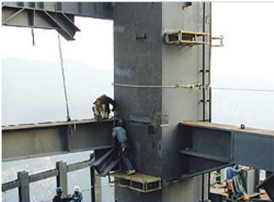
Figura 10. Ensamblaje de vigas reticuladas y ubicación de rigidizadores de alma
