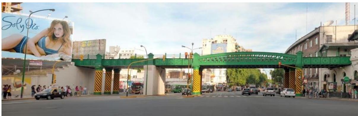
Figura 3 – Configuración del puente post intervención. Vistas al Norte (sup.) y al Sur (inf.)
