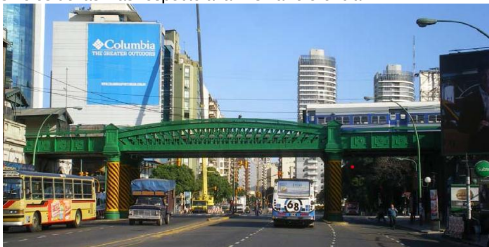
Figura 1 – Configuración del puente previa a la intervención. Vista al Norte
