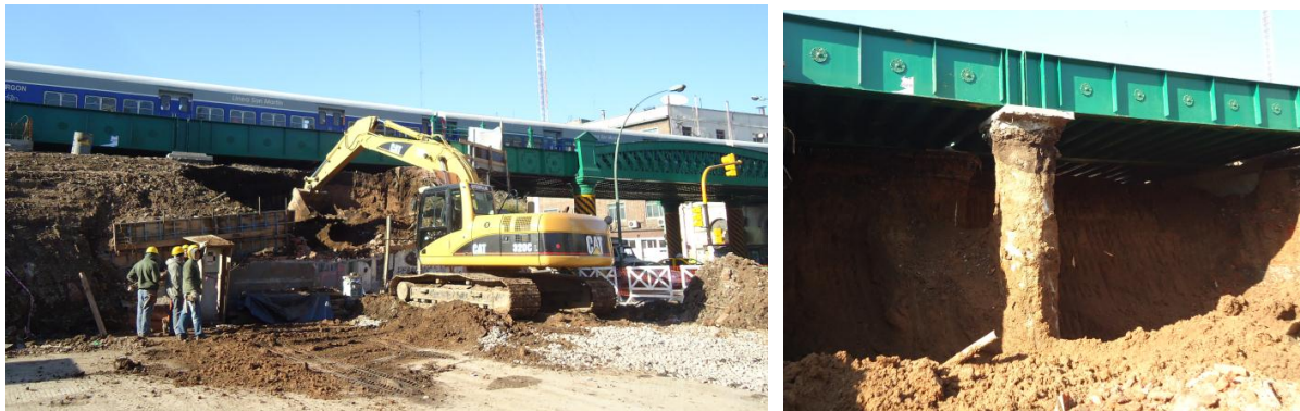
Figura 9 – Trabajos de excavación luego del montaje del puente.
