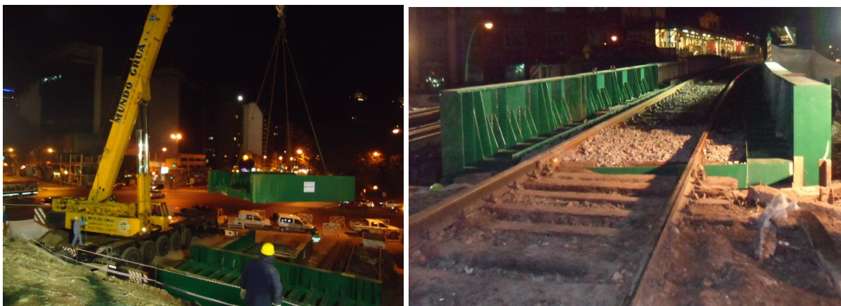
Figura 8 – Trabajos de montaje de los tramos de puente.
