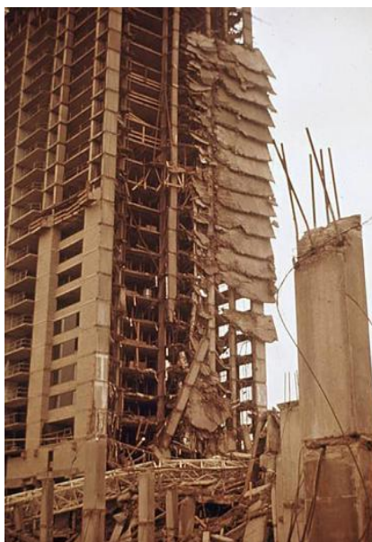
Figura 1: Colapso progresivo vertical y horizontal del Skyline Plaza Apartments en EE.UU.
