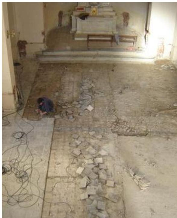
Figura 14: Retiro de las piezas de solados y zócalos
