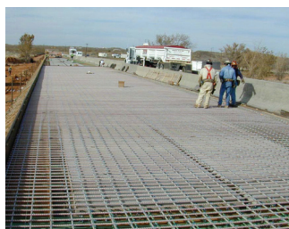
Figura 2: Varões de GFRP em tabuleiro de ponte.
