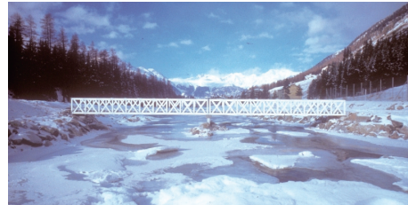
Figura 14: Ponte Pontresina (Suíça) totalmente construída com perfis pultrudidos de GFRP [12].
