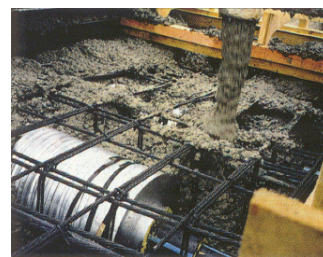
Figura 3: Varões de CFRP em tabuleiro de ponte [9].
