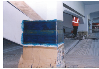
Figura 8: Mantas de CFRP no reforço do Viaduto Duarte Pacheco.
