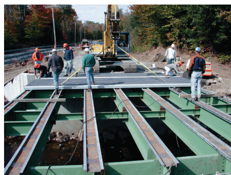
Figura 12: Substituição de tabuleiro por painéis multicelulares pultrudidos em GFRP colados a longarinas metálicas.
