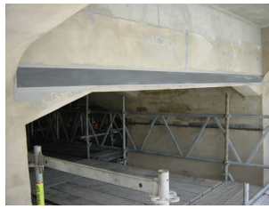
Figura 7: Laminados de CFRP no reforço do Viaduto Duarte Pacheco.
