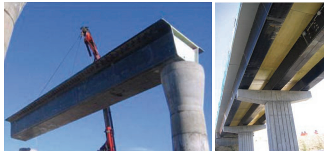
Figura 10: Vigas moldadas com reforço em fibras de carbono (à esquerda) e carbono/vidro (à direita) [14].
