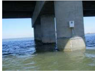
Fig.5 – Protecção com fibra de vidro de pilares
