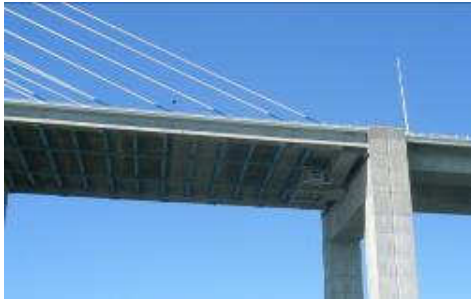
Fig.4 – Veículo de inspecção da ponte
