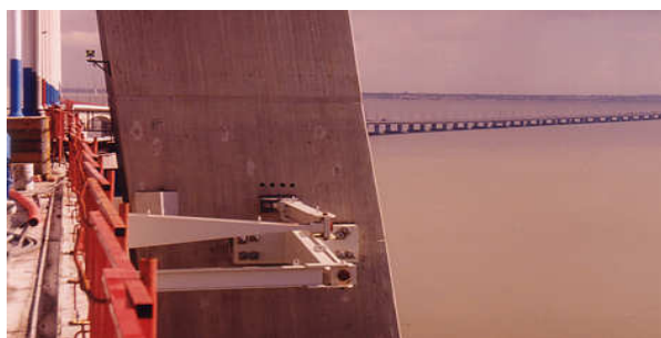
Fig.3 – Amortecedores do tabuleiro
