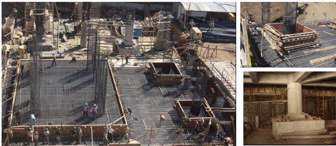
Fig. 22. Ejemplo de edificio de 90 m de altura con losa de cimentación y ábacos
