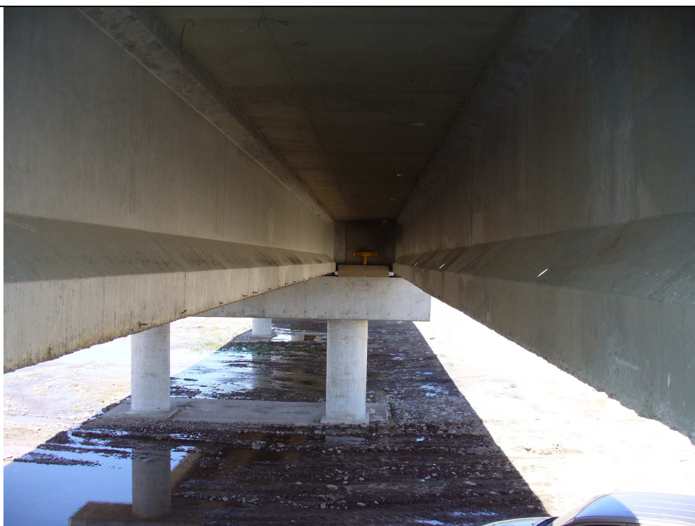
Fotografía N° 1- Vista a lo lejos de la ubicación del disipador. Puente en Sorocayense, provincia de San Juan.
