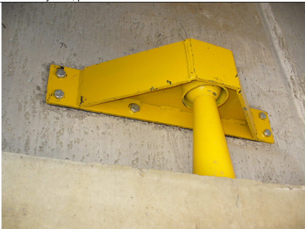
Fotografía N° 2 – Disipador utilizado en el puente en Sorocayense.
