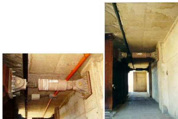
Figura 8. Puente Amolanas (Chile).
