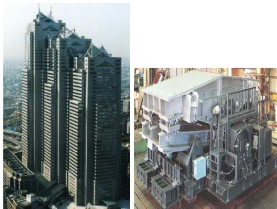
Figura 14. a). Shinjuku Tower (Japón). b). Sistema HMD implementado en el edificio.
