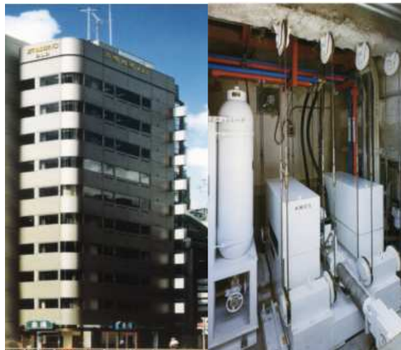
Figura 13. a). Kyobashi Seiwa Building (Japón). b). Sistema AMD implementado en el edificio.
