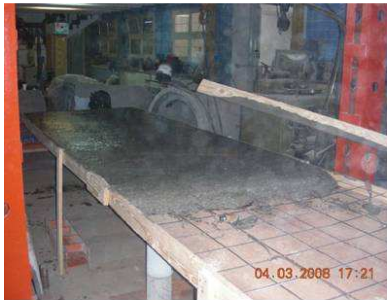
Figura 12: Hormigonado del prototipo
