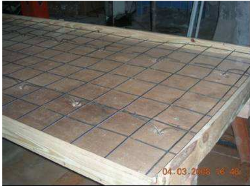
Figura 11: Disposición de los conectores
