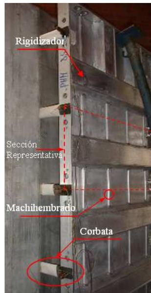
**Figura 1.** Conformación general del sistema.
