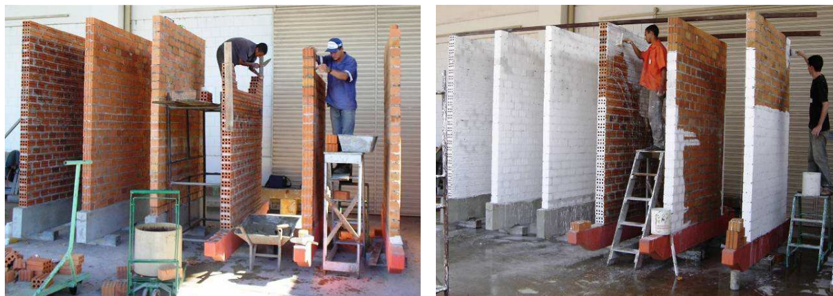
Figura 4 – Fase final do assentamento de blocos cerâmicos
