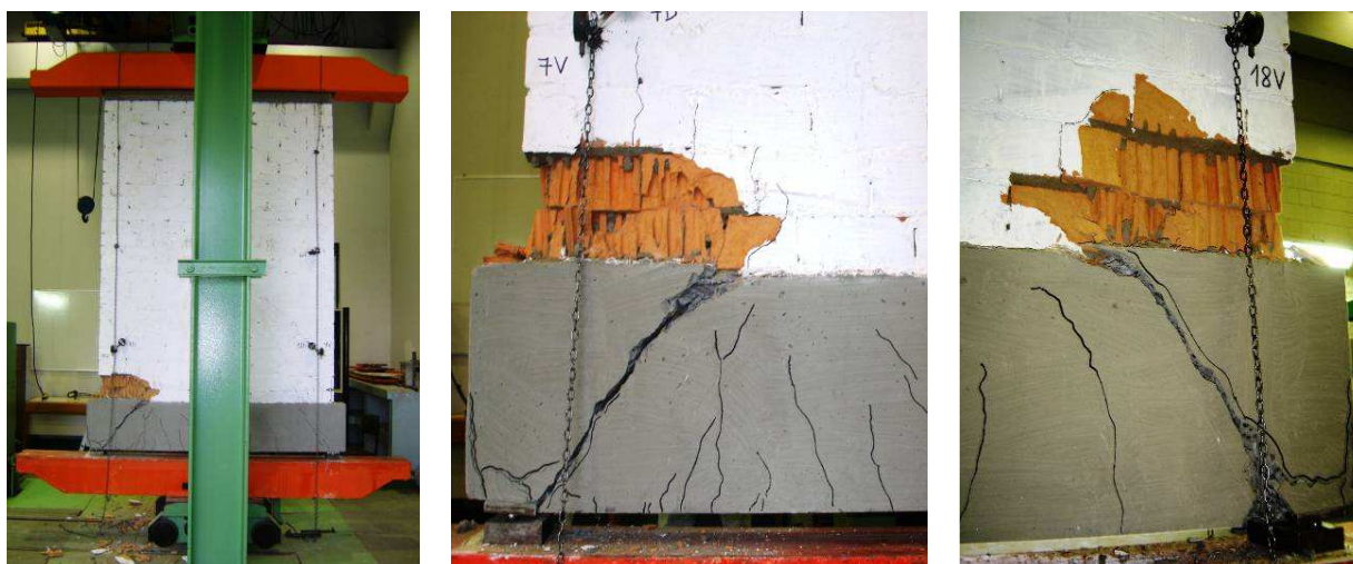
Figura 18 – parede com blocos cerâmicos estruturais de 21 furos - base elástica
