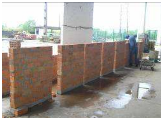
Figura 3 – Confeção das paredes
