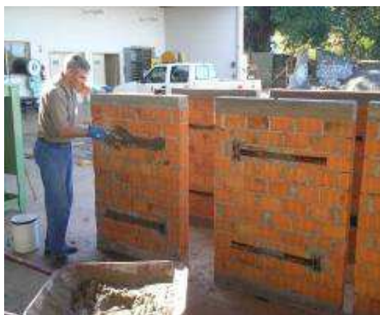
Figura 5 – Instalação da tubulação, preenchimento dos cortes e pintura das paredes
