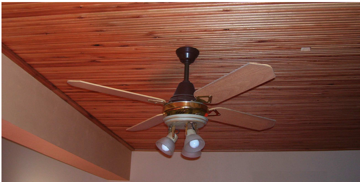
Figura 5: Vista inferior del cielorraso
