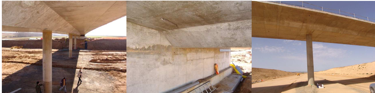
Figura 1: Fotos del puente instrumentado. a) Vista inferior desde el estribo 1. Tablero rígidamente unido al estribo (b). Pila empotrada en el tablero (c).
