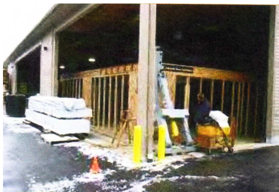
Configuración de casa tipo 3a: Se pueden observar detrás de la columna de soporte del techo del área laboratorio los arriostramientos de esquina de 1.20 m.
