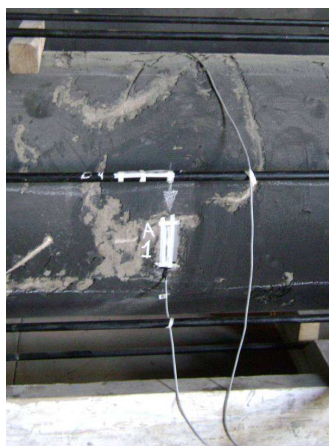
Figura 4: Disposición de una de las bandas extensométricas, banda A, sobre el ducto.
