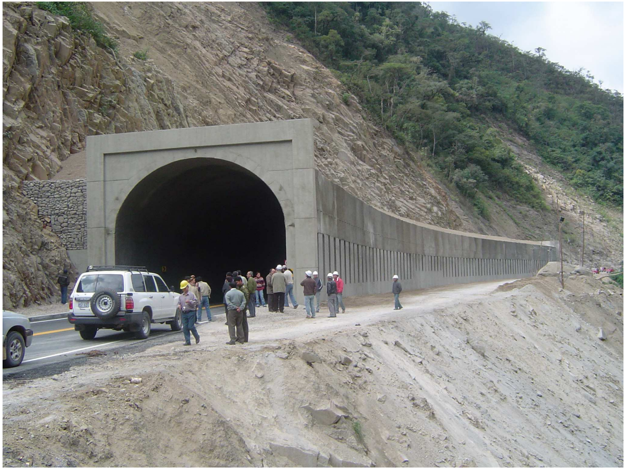
Fotografía No. 1: Túnel falso – obra concluida (2005)
