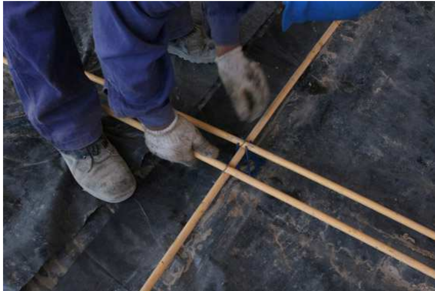
Fig 7. Colocación de los cordones sobre soportes plásticos
