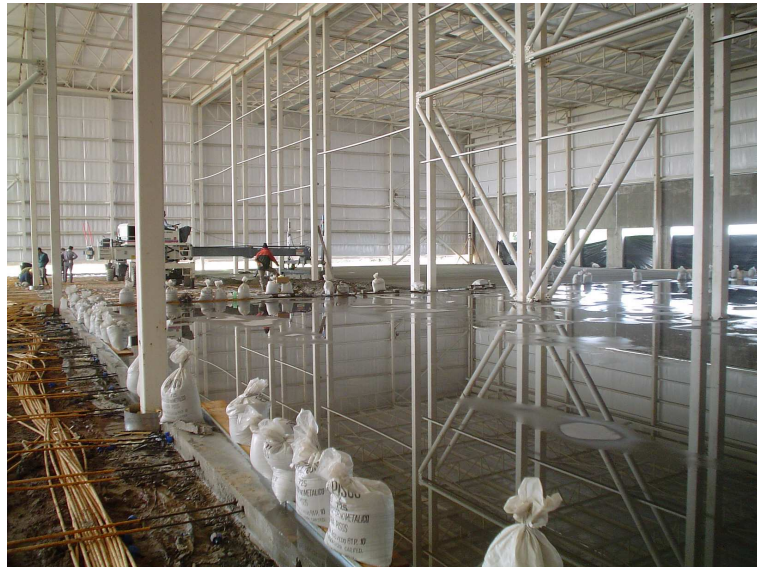
Fig 6. Curado de la losa de piso
