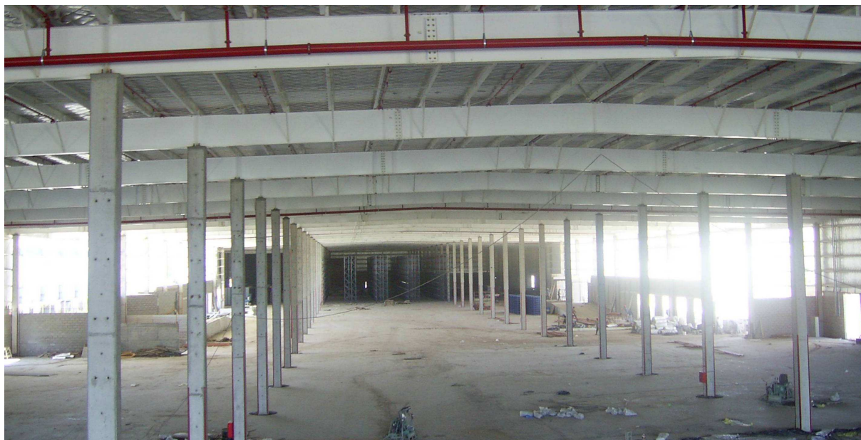
Fig 20. Paños de más de 100 m de longitud sin fisuras
