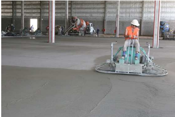
Fig 13. Llanoado mecánico
