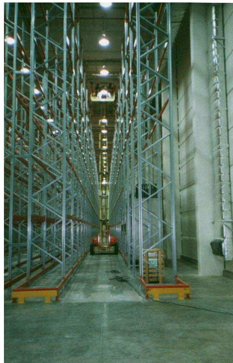
Fig (2). Uso creciente de estanterías y autoelevadores en pisos industriales, con requerimiento de eliminación de juntas. (Obra: Planta Bayer, Pilar)
