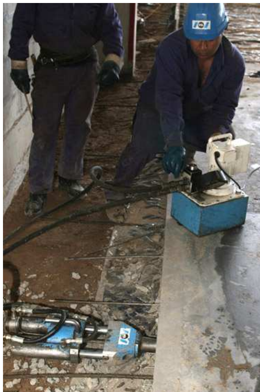
Fig. 14. Tesado de los cordones
