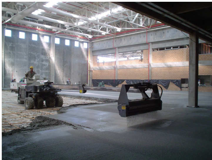
Fig 12. Vaciado continuo. Espolvoreado con brazo telescópico
