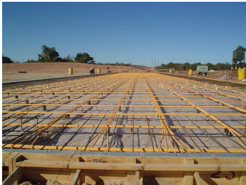
Fig 8. Pavimento postesado listo para ser hormigonado
