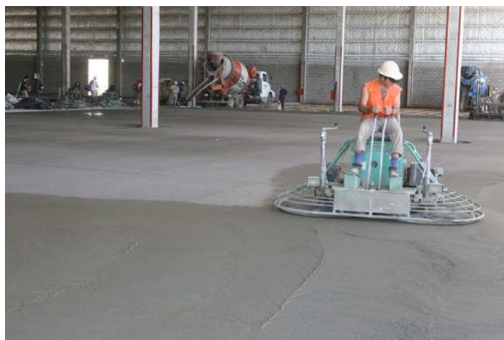
Fig 19. Llanoado mecánico
