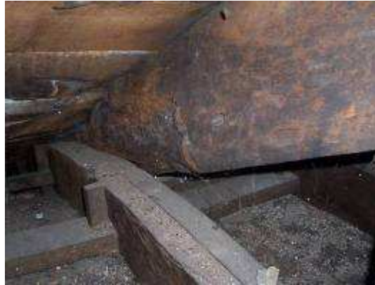
Figura 5 - Unión entre viga y arco
