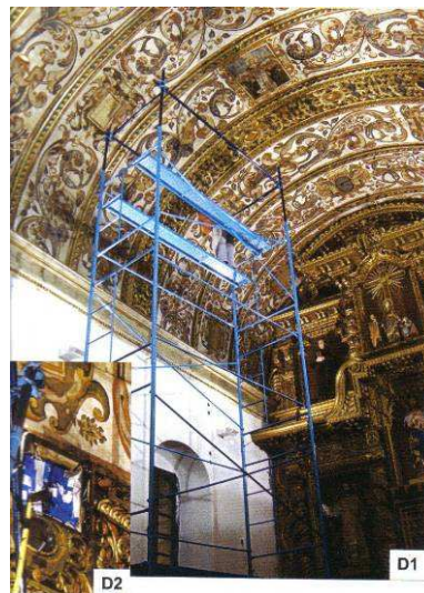
Fig. 20 – Toma de Gammagrafías desde el interior
