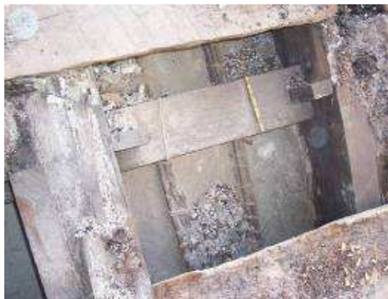
Figura 6 - Sujeción del cielorraso
