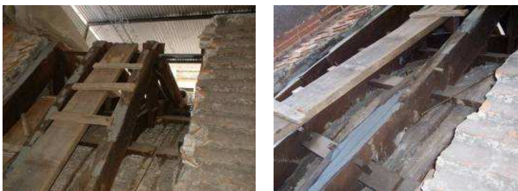
Figura 11 – Reparación con resina epoxi terminada
