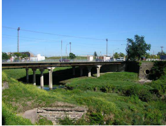
Figura 1- Vista del puente sobre el Arroyo Tapalqué
