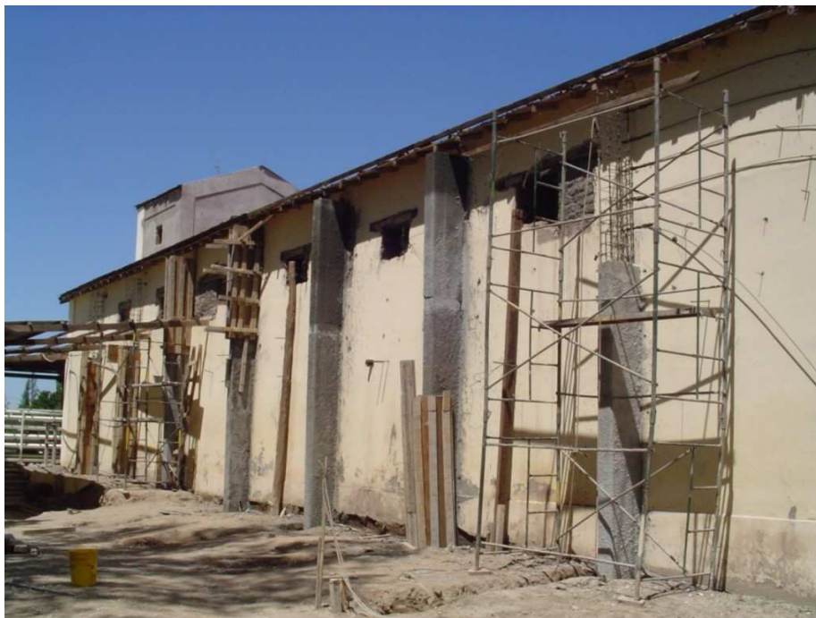
Figura 12. Vista del muro Este durante la construcción de las columnas de refuerzo.
