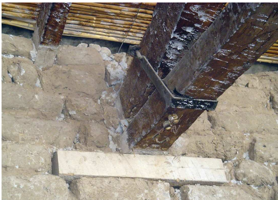
Figura 4. Vista del apoyo de la viga reticulada de madera sobre el muro de adobe.
