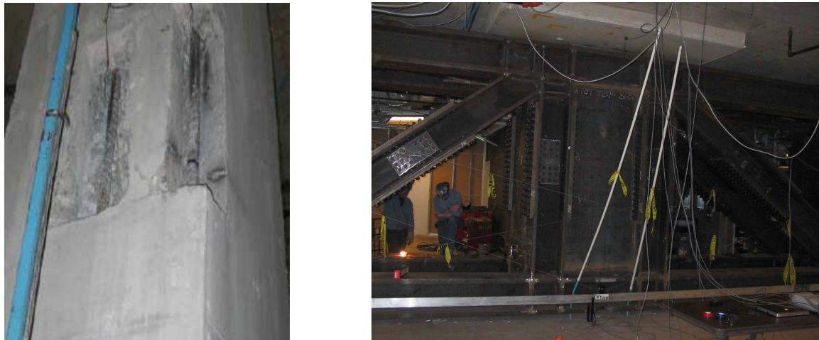
Fig. 18: Ubicación de los extensómetros en la sección media de la columna y de los LVDT y viga de referencia para medición de las deformaciones en el reticulado.
