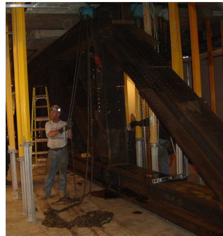
Fig. 15: Transportación e Izamiento del Reticulado Pratt por Mitades. Montaje de las Mitades.
