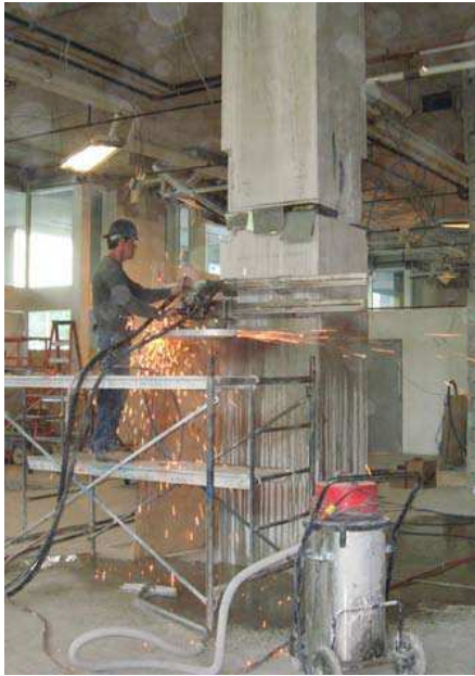
Fig. 27: Corte final de la columna. Perforación del núcleo de hormigón remanente de la columna.
