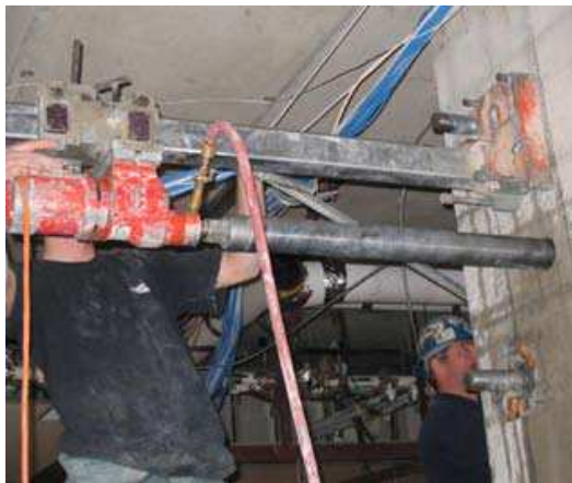
Fig. 17: Perforación precisa de la columna. Colocación de los pernos de fijación e inyección con lechada de cemento a presión
