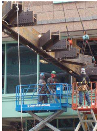
Fig. 15: Transportación e Izamiento del Reticulado Pratt por Mitades. Montaje de las Mitades.
