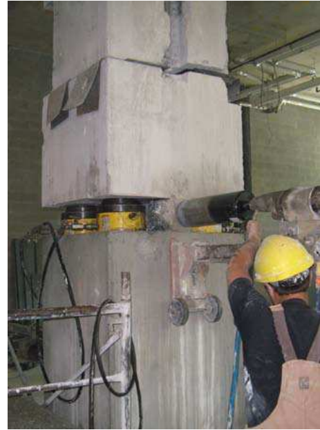
Fig. 27: Corte final de la columna. Perforación del núcleo de hormigón remanente de la columna.
