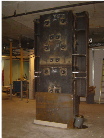
Fig. 9: Puntal de transferencia soldado a placa de acero a cada lado de la columna. Esquema – corte transversal.
