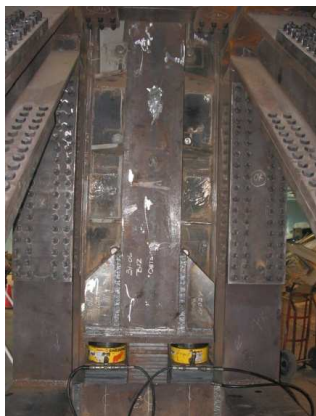
Fig. 10: Sistema para aplicación de la precarga a través de gatos hidráulicos (2 por lado): Puntal con ménsulas y viga de transferencia conectada al cordón inferior de los reticulados. Esquema – corte transversal.
