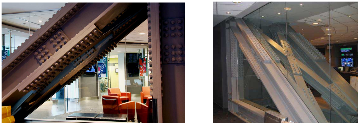
Fig. 8: Extremo del reticulado Pratt visto desde la sala de control hacia la antesala de espera y desde la antesala hacia la sala de control.
