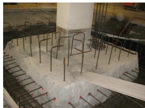
Fig. 13: Detalles para refuerzo de las columnas adyacentes. Zapata de fundación reforzada preparada para ser hormigonada.
