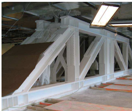
Fig. 16: Reticulados Pratt terminados con protección ignifuga.
