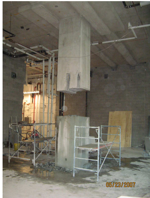
Fig. 27: Corte final de la columna. Perforación del núcleo de hormigón remanente de la columna.
