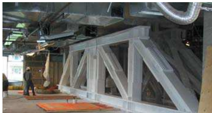
Fig. 16: Reticulados Pratt terminados con protección ignifuga.
