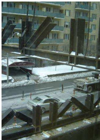
Fig. 15: Transportación e Izamiento del Reticulado Pratt por Mitades. Montaje de las Mitades.
