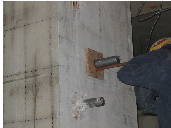
Fig. 17: Perforación precisa de la columna. Colocación de los pernos de fijación e inyección con lechada de cemento a presión
