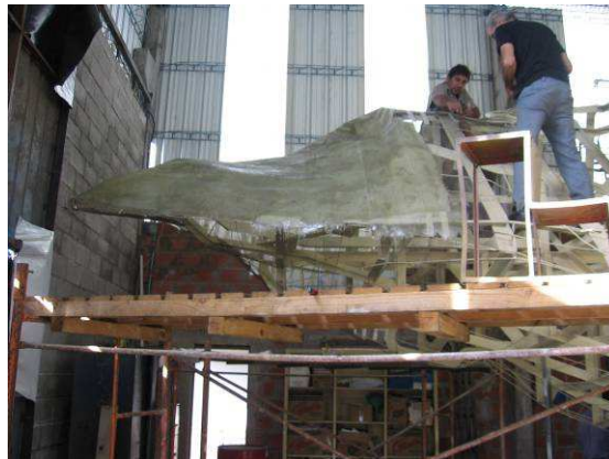
Figura 16: Construcción de la Cubierta
