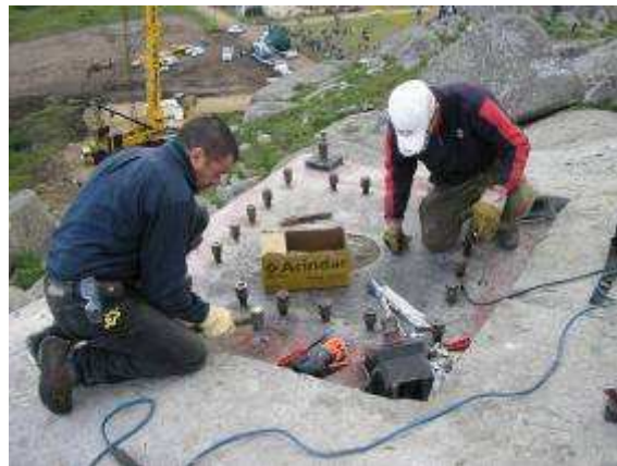
Figura 18: Placa de anclaje y bulones
