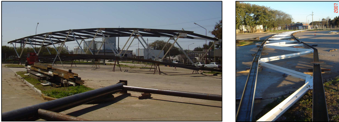
Fig. 18 – Fotos del premontaje de un módulo típico de cerchas en taller
