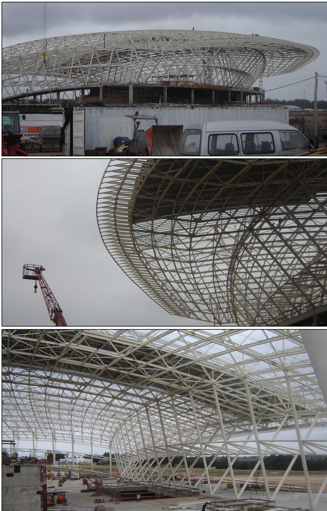
Fig. 25 – Fotografías con vistas generales de la estructura montada a junio de 2008.
