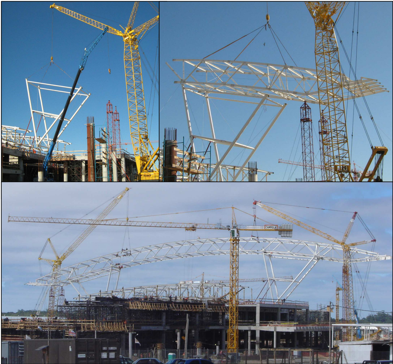
Fig. 22 – Secuencia de fotos montaje módulo central
