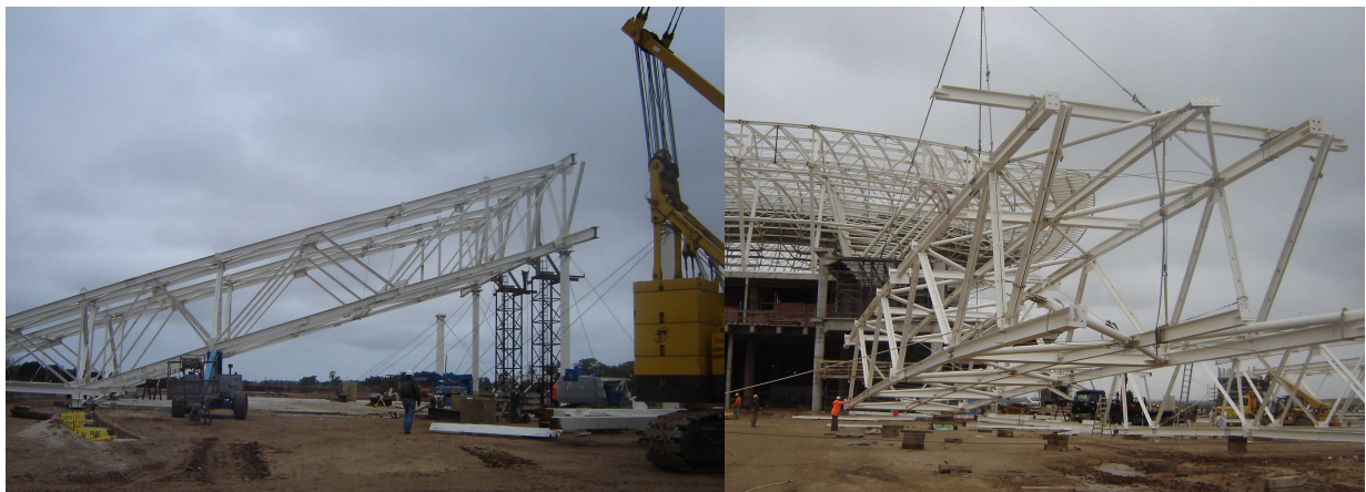
Fig. 24 – Fotografías con módulo 1 en posición y comienzo del izado del tramo 2.
