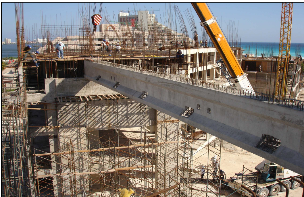
Fig. 8. Montaje de las vigas premoldeadas (II).
