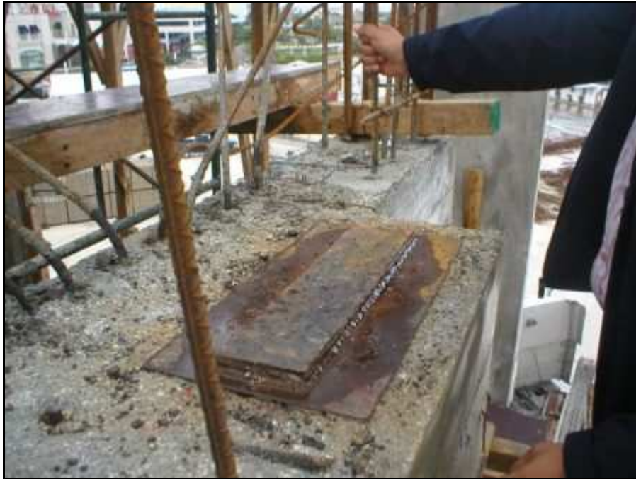
Fig. 10. Placa de apoyo de las vigas premoldeadas.
