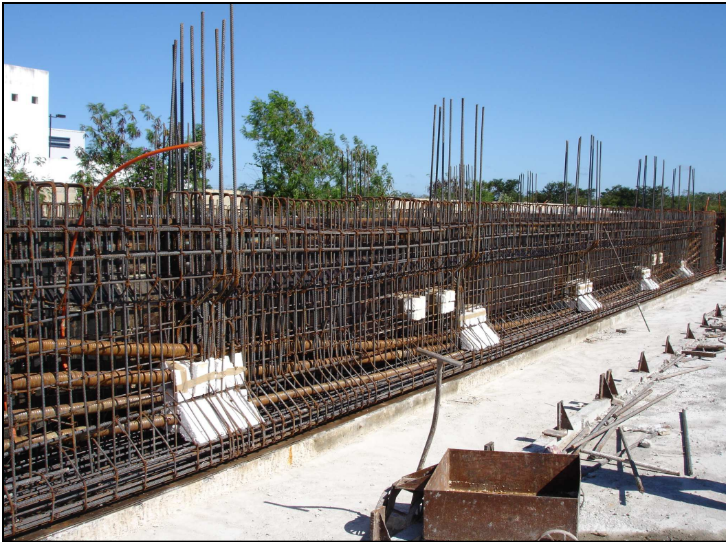
Fig. 2. Viga premoldeada en planta de fabricación.
