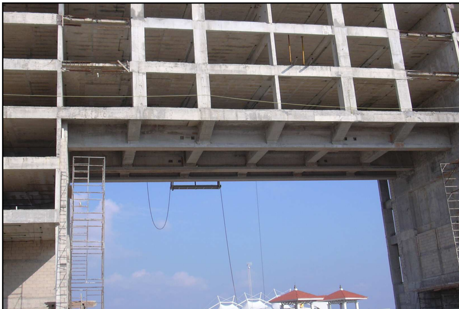
Fig. 11. Vista frontal del edificio.
