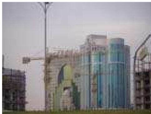
Figura 10: Edificio en Doha, Qatar
